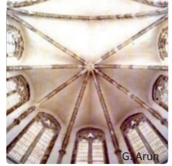
Tonozların kesiştirilmesi: a) Manastır tonozu, b) Çapraz tonoz, c) Dilimli tonoz, d) Nervürlü (kaburgalı) tonoz
