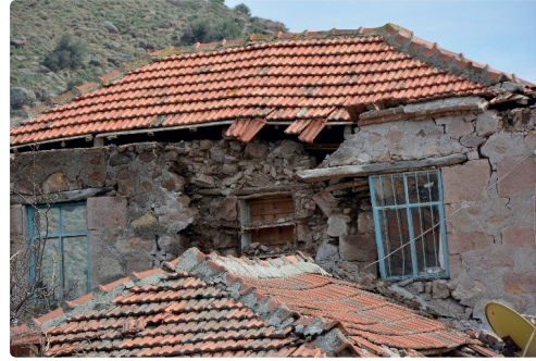
Şekil 7.11. Çatı elemanı mesnetinde duvar tabakasının düzlem dışı doğrultuda zorlanması.
