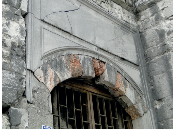
Şekil 4.15 Özensiz kullanıcılar tarafından yapılan söve onarımında çimentolu harç kullanımı (Z. Ahunbay).
