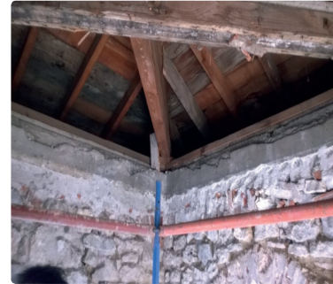
Şekil 7.12. Çatı elemanlarının duvar üzerinde teşkil edilmiş hatılla mesnetlenmesi.
