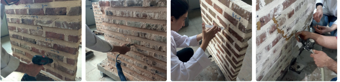
Şekil 7.2 a) Duvar üzerine matkap ile delik açılması, b) Açılan noktaların basınçlı hava ile temizlenmesi, c) Islatma işlemi, d) Enjeksiyon uygulaması.
