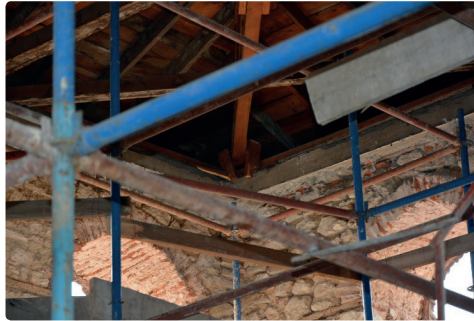
Şekil 7.12. Çatı elemanlarının duvar üzerinde teşkil edilmiş hatılla mesnetlenmesi.
