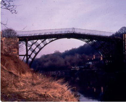
Coalbrookdale Köprüsü, İngiltere 1779, ilk dökme demir (font) köprü.
