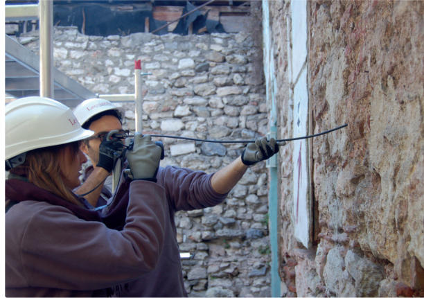
Şekil 3.6 Yapıda endoskopinin uygulanması (O. Aydemir).
